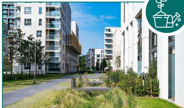
Hemelwaterinfiltrerende strook en wadi © Provincie Antwerpen
